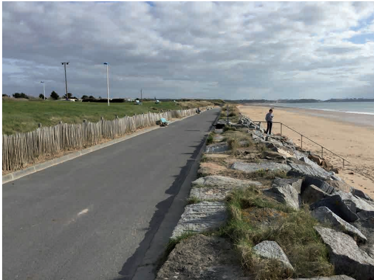
Végétalisation des enrochements, Coudeville-sur-mer.
