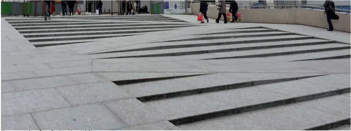
Rampe intégré, Paris 13ème.
