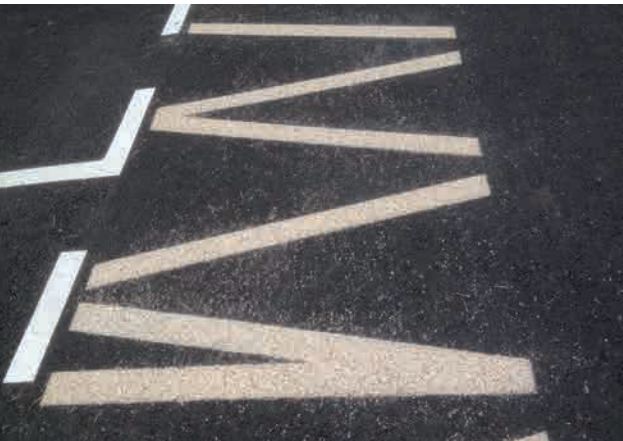
Marquage au sol en résine, La Bernerie-en-Retz.
