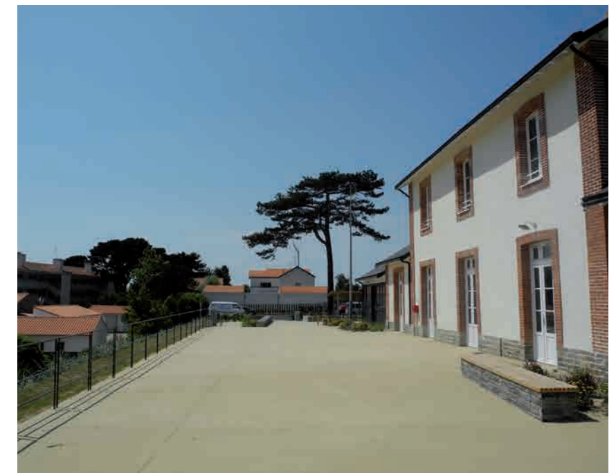
Parvis de la gare, La Bernerie-en-Retz, Phytolab.
