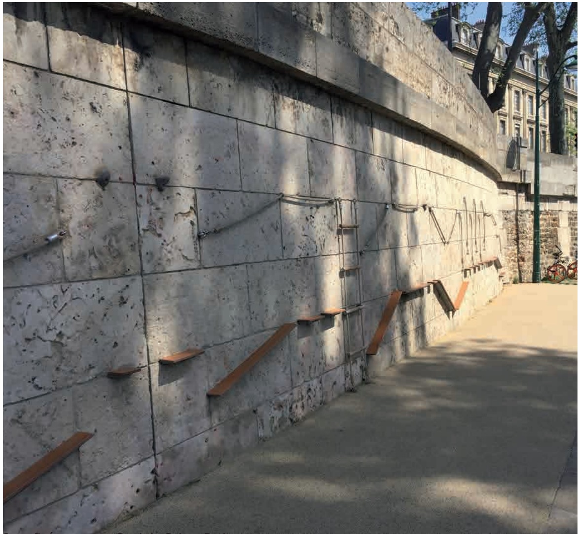
Jeux fixes sur mur, Quai de Seine, Paris.
