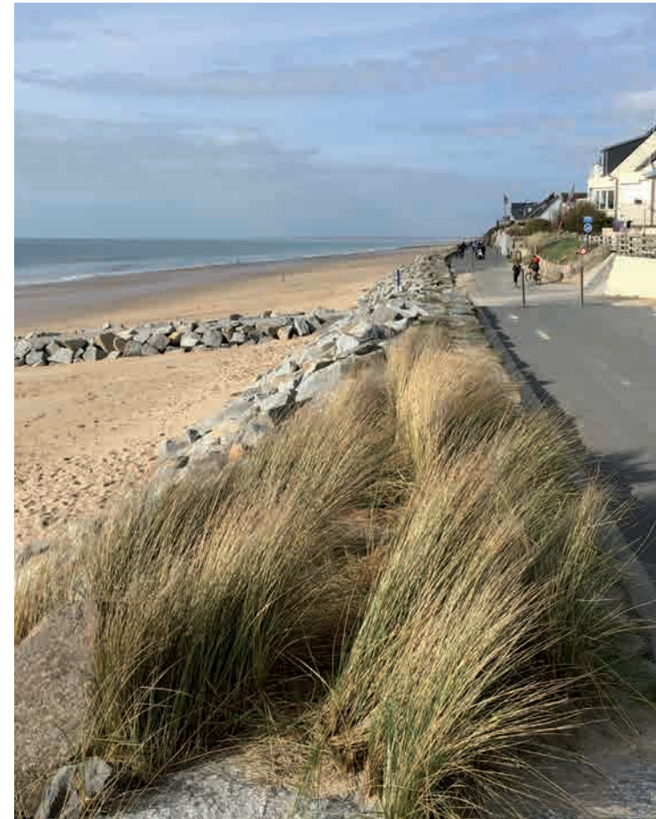
Végétalisation des enrochements, Coudeville-sur-mer.
