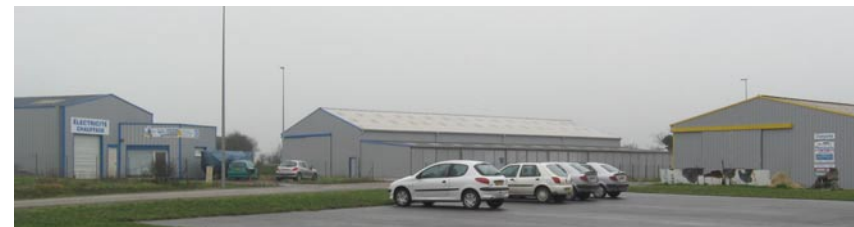
Une opération réfléchie : une unité de formes, couleurs et de matériaux. Seules les rives d'angles différencient chacune des activités.
