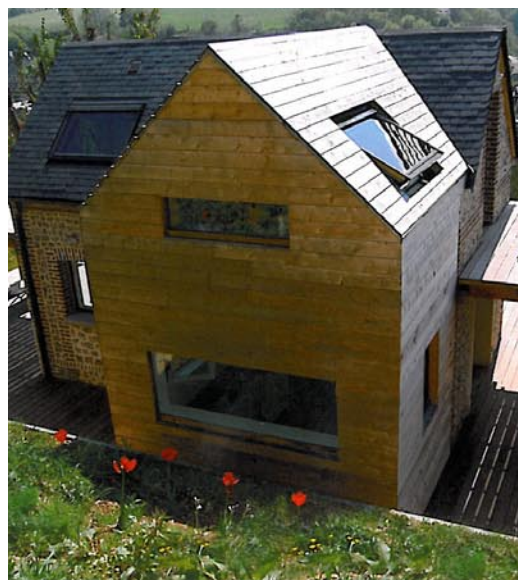
Le bois utilisé en parement des façades
