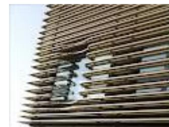
Brise soleil horizontal : Lutte contre les rayons solaires d'été sur la façade Sud
