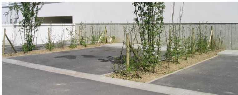
Plantations arbustives intégrant les places de stationnement.
