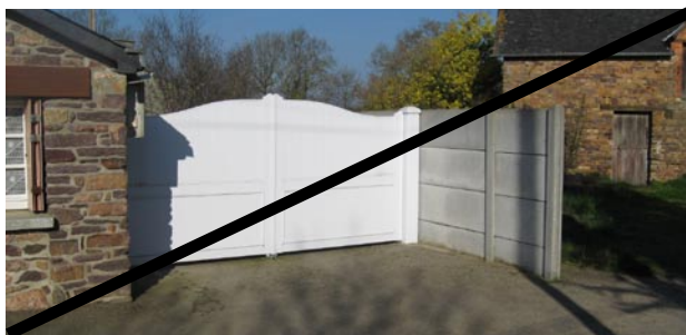
A éviter : le PVC blanc et le parpaing non enduit, en rupture avec les matériaux locaux et anciens
