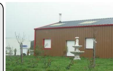
Pour une plus grande sobriété, éviter de peindre les rives d'angle des bâtiments dans des couleurs criardes
