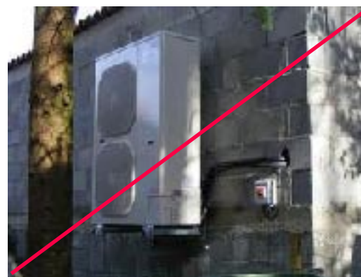
Un système d'aérothermie «camouflé» dans une structure prolongeant la façade.
