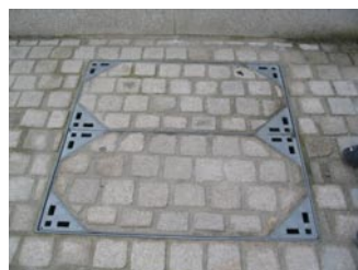
Local à poubelles chaché derrière un bardage bois. Les coffrets peuvent être discrètement dissimulés dans les pavages.
