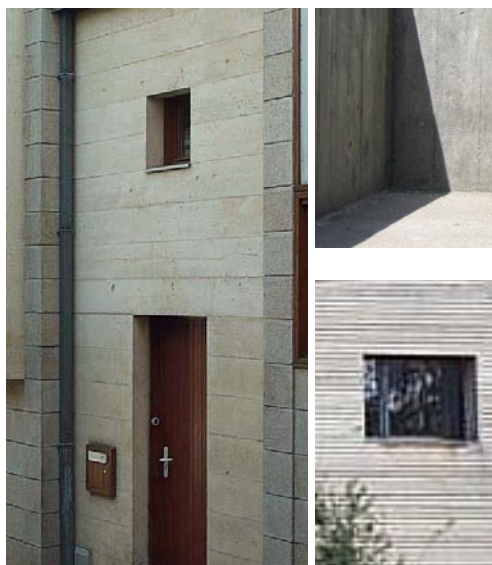
Utilisation de béton banché pour une extension
